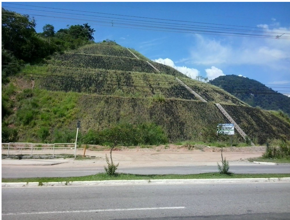
Figura 7 - Retaludamento do Morro do Tatu após remoção de ocupações ilegais Foto: Ana Cristina da Silva
