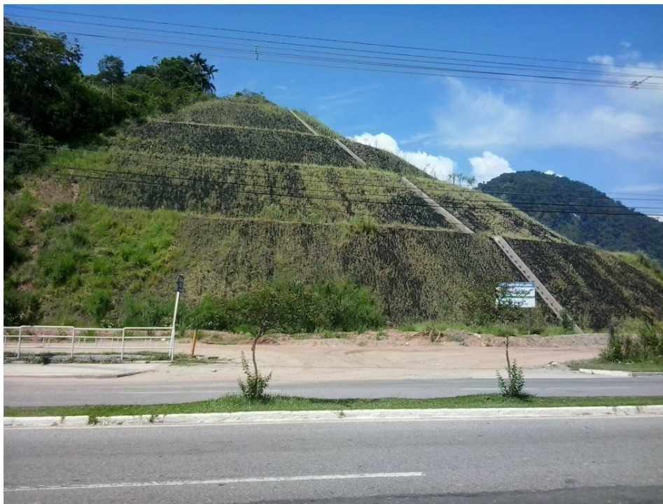
Figura 7 - Retaludamento do Morro do Tatu após remoção de ocupações ilegais Foto: Ana Cristina da Silva
